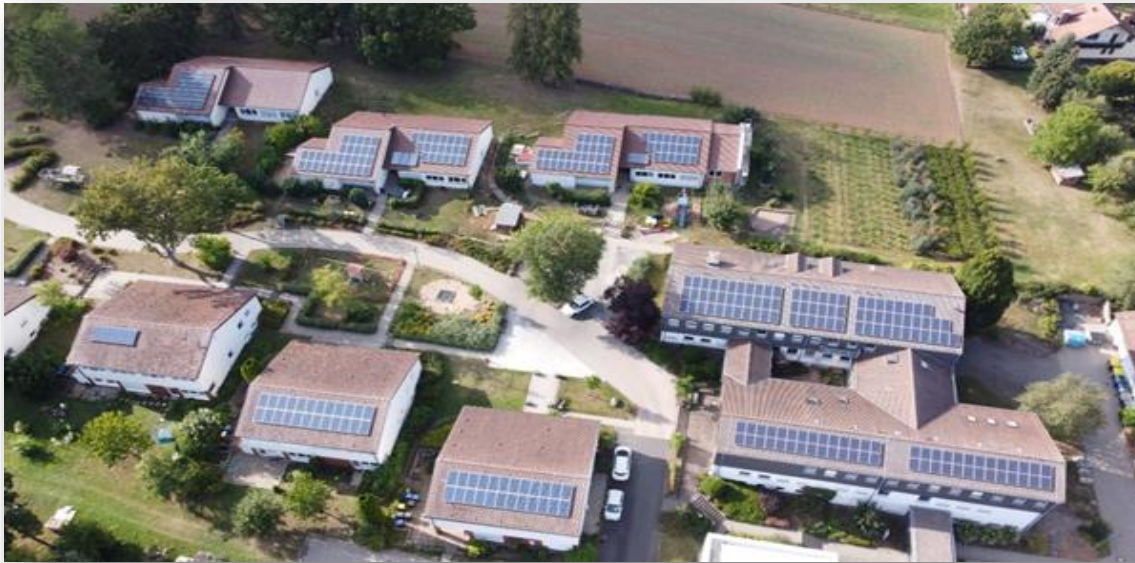
Das Bild das Gelände des Jugendhilfeverbundes in Maberzell mit einer Vielzahl an Photovoltaik- und Solarthermie Anlagen.
