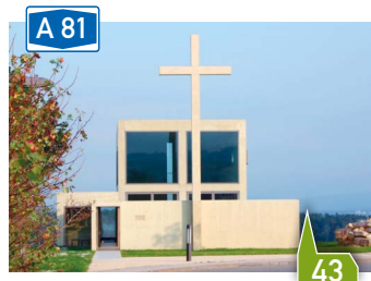
Ökum. Autobahnkapelle „Emmauskapelle“, Engen
